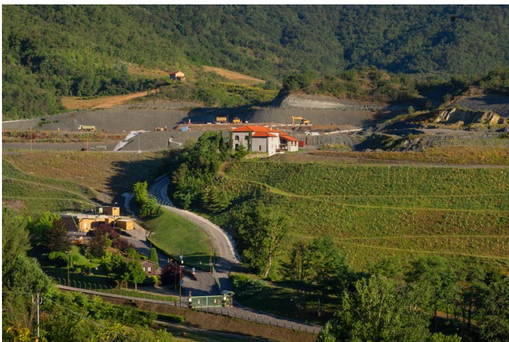
La Cascina Vallone in ristrutturazione delimita l'area operativa de La Filippa (alla sua sinistra). A destra del fabbricato (sopra e sotto) invece, è in corso di completamento la sistemazione della vecchia cava con elementi naturali (senza rifiuti).
